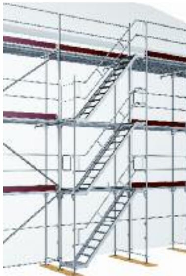
Acceso a obra y andamio con escalera de aluminio por tramos adosada al andamio.
